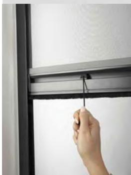
A l'aide de la vis noire insérée dans les butées, bloquer la butée basse CLIC-CLAC en position, sans que le joint brosse de la barre de charge ne soit comprimé, il doit juste toucher le bas de la fenêtre.
